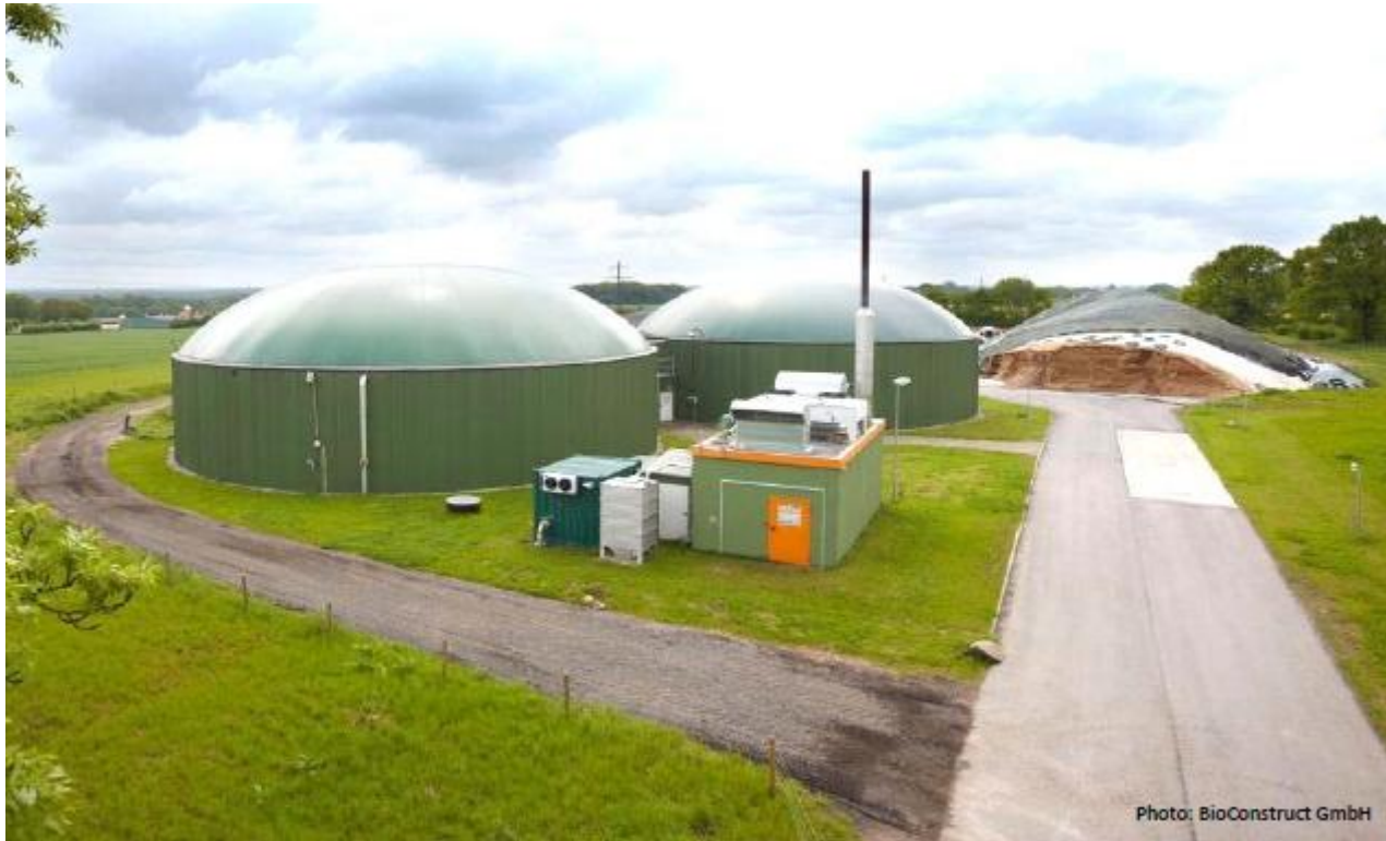
Σχήμα 1: Μονάδα παραγωγής βιοαερίου και ηλεκτρικής ενέργειας από βιοαέριο ισχύος 500 kW (Chair of Bioprocess Engineering, TU-Berlin)
