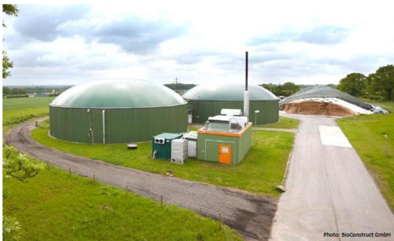
Σχήμα 3: Μονάδα παραγωγής βιοαερίου και ηλεκτρικής ενέργειας από βιοαέριο ισχύος 500 kW (Chair of Bioprocess Engineering, TU-Berlin)
