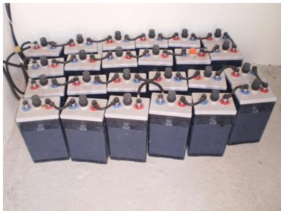
Σχήμα 14: Συστοιχίες μπαταριών φωτοβολταϊκών εφαρμογών.
