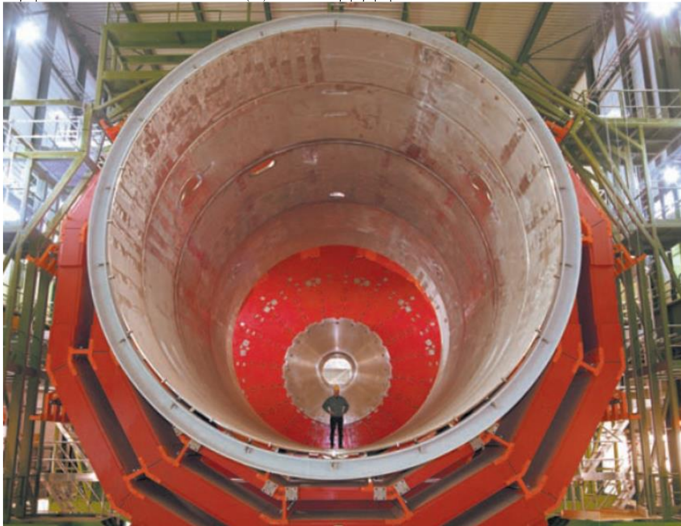
Μεγάλο υπεραγώγιμο σωληνοειδές πηνίο στο CERN
