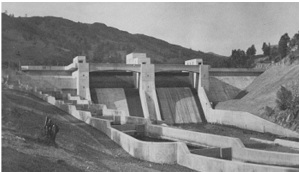
Εικ. 1.16: Φωτογραφία που παρουσιάζει μία κατασκευή σκάλας διέλευσης ιχθύων (Fish ladder) σε ένα φράγμα.
