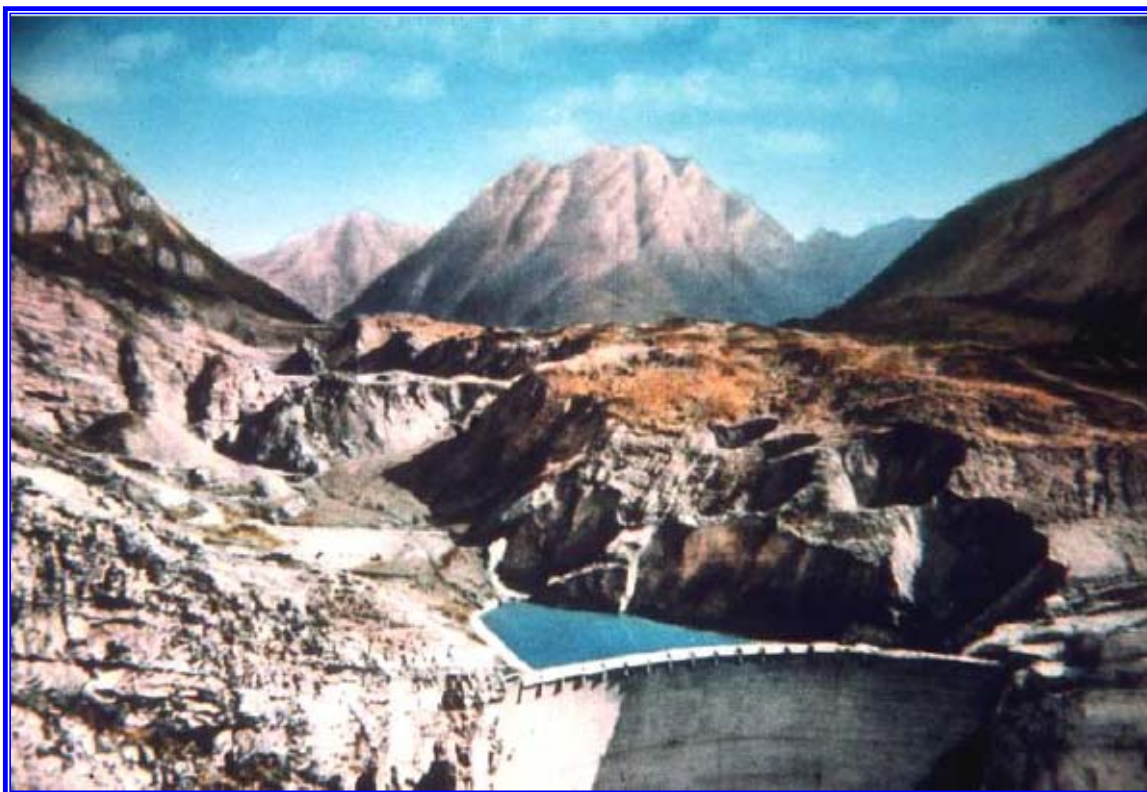
Εικ. 1.9: Κατά την διάρκεια της πλήρωσης με νερό της λεκάνης κατάκλισης (ταμιευτήρα) του φράγματος Vajont, ο πόδας (βάση) του μετώπου του πρανούς του ορεινού όγκου Τος βυθίστηκε και αυτό προκάλεσε την κατολίσθηση. Το «βουνό» με τα υλικά κατολίσθησης διακρίνονται στο κεντρικό τμήμα της φωτογραφίας. Η εξαιρετικά γρήγορη κάθοδος των υλικών της κατολίσθησης εκτόπισε το νερό στον ταμιευτήρα προκαλώντας ένα τεράστιο κύμα ύψους 100 m που πήδηξε τον τοξωτό τοίχο από σκυρόδεμα του φράγματος και παροχετεύτηκε προς τα καπάντη. Ο τοξωτός τοίχος του φράγματος από σκυρόδεμα, όπως φαίνεται μπροστά στην φωτογραφία, έμεινε σχεδόν άθικτος.
