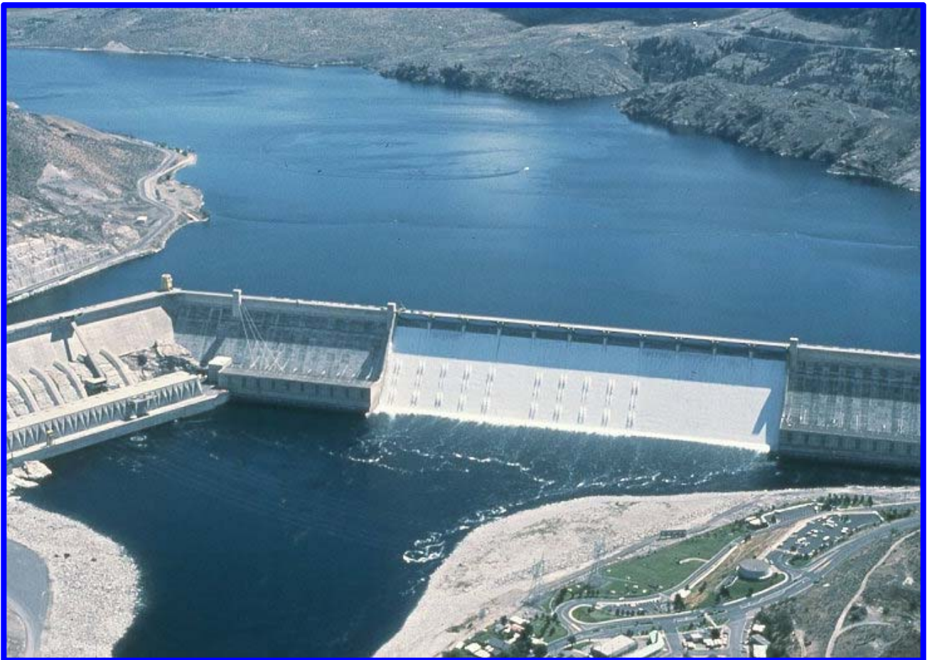
Εικ. 1.6: Το φράγμα GRAND COULEE. Σκοποί: Υδροηλεκτρική ενέργεια, Άρδευση & Έλεγχος πλημμυρών.
