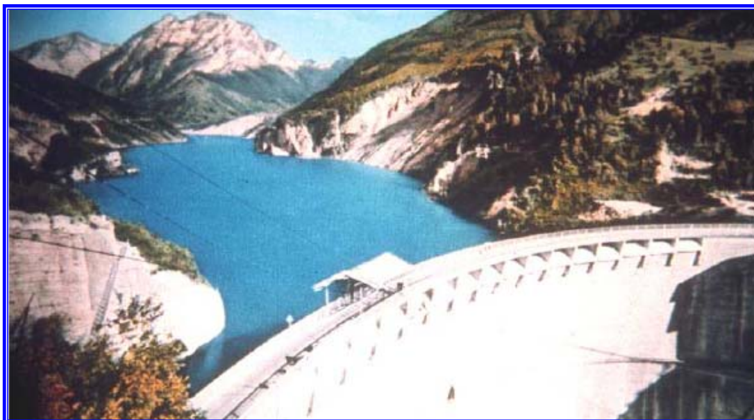
Εικ. 1.8: Το φράγμα Vajont κατά την διάρκεια πλήρωσης της λεκάνης κατάκλισής του (ταμιευτήρα). Στο μέσον της απόστασης, στο κέντρο της φωτογραφίας, βρίσκεται το ύψωμα Τος με το ασταθές πρηνές όπου διακρίνεται η λευκή «ρωγή εφελκυσμού» στο μέτωπο του ορεινού όγκου ακριβώς επάνω από την επιφάνεια του νερού.
