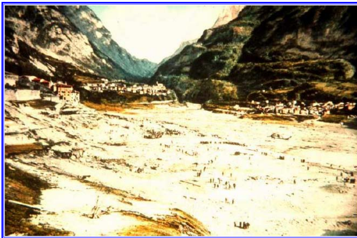
Εικ. 1.11: Άποψη των «ερείπων» της πόλης του Longarone, αμέσως μετά από την πλημμύρα που προκλήθηκε από υπερπήδηση του νερού από τον τοξωτό τοίχο του φράγματος από σκυρόδεμα σαν αποτέλεσμα της αστοχίας και της ταχύτατης καθόδου των υλικών κατολίστησης του ορεινού όγκου Τος. Περισσότεροι από 2.000 άνθρωποι έχασαν την ζωή τους από την πλημμύρα.
